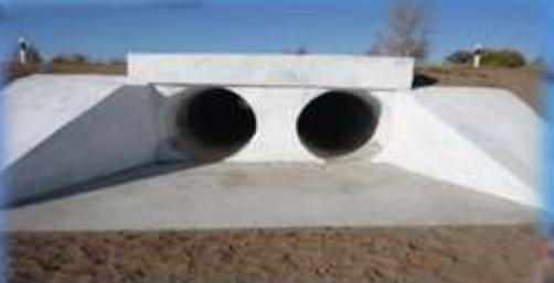
По восстановлению водопропускных труб, лотков устройство оголовков и на водопропускную трубу ул. Вокзальная г. Приморск, ул. Прибрежная, п. Балтийское
